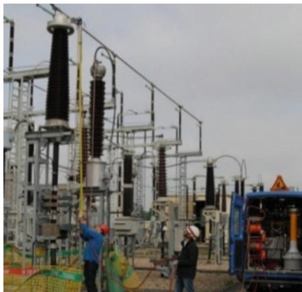
**Figure 7** Illustration d'une recherche de défaut depuis un poste (RTE)
